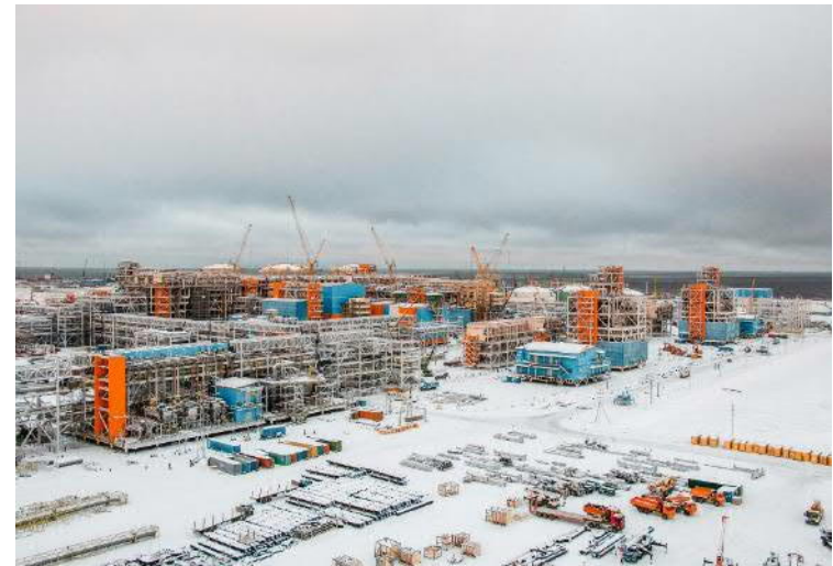
Jamalin LNG-laitos rakenteilla
