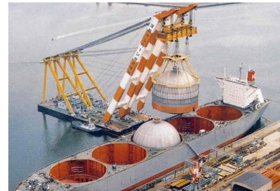
Pallotankkia nostetaan laivaan
