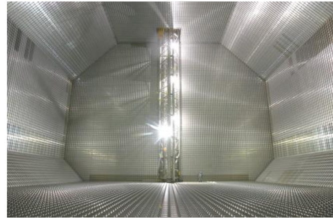
Membraanitankki sisältä nähtynä
