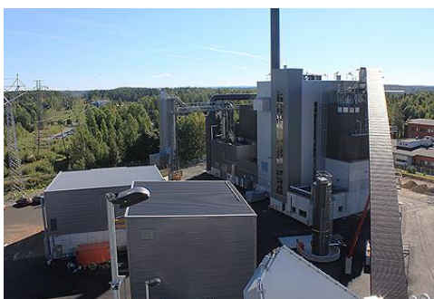
Hervannan hakelämpölaitos 30 milj. e
