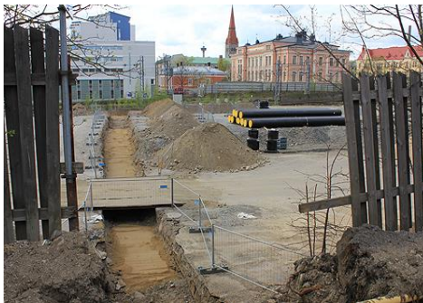
Kaukojäähdytysverkon rakentaminen 2012 lähtien (8,5 km tähän mennessä)
